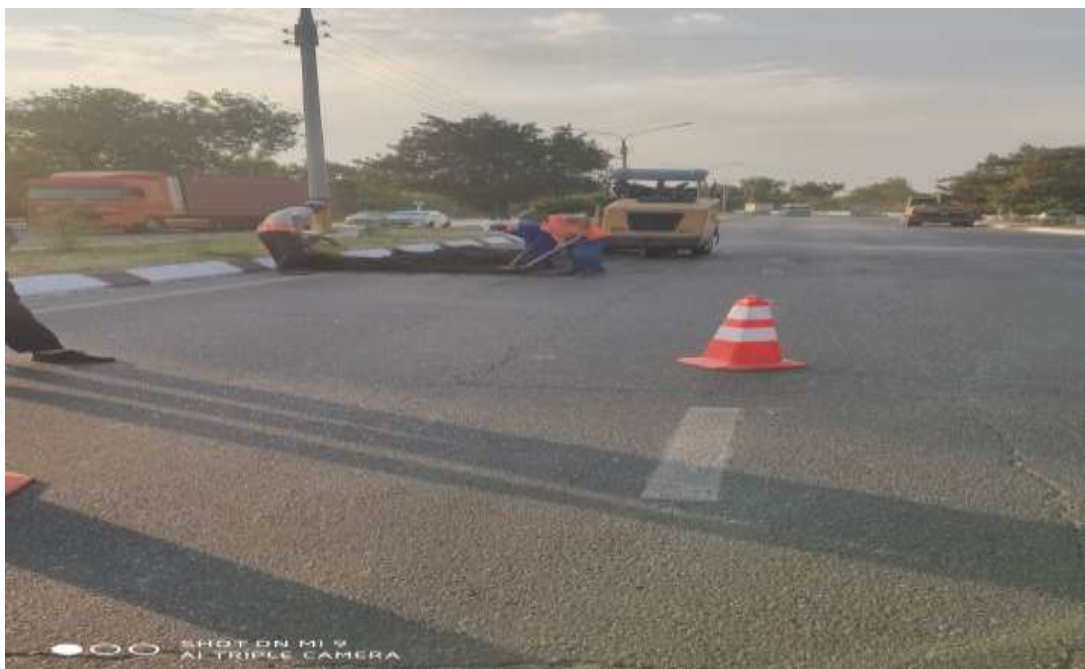
6-rasm. Ta'mirlanayotgan yo'l bo'lagidagi yo'l belgi va to'siqlarni o'rnatilgan holati.
