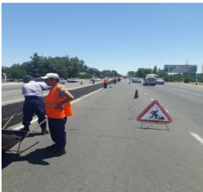
5-rasm. Ta'mirlanayotgan yo'l bo'lagidagi yo'l belgi va to'siqlarni o'rnatilgan holati.
