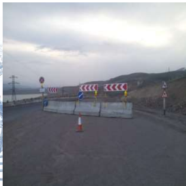
5-rasm. Ta'mirlanayotgan yo'l bo'lagidagi yo'l belgi va to'siqlarni o'rnatilgan holati.
