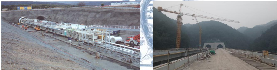
2-rasm. Tonnelni qurishda mexanizatsiyalashgan yer ostini qazib o'tish majmuasi
