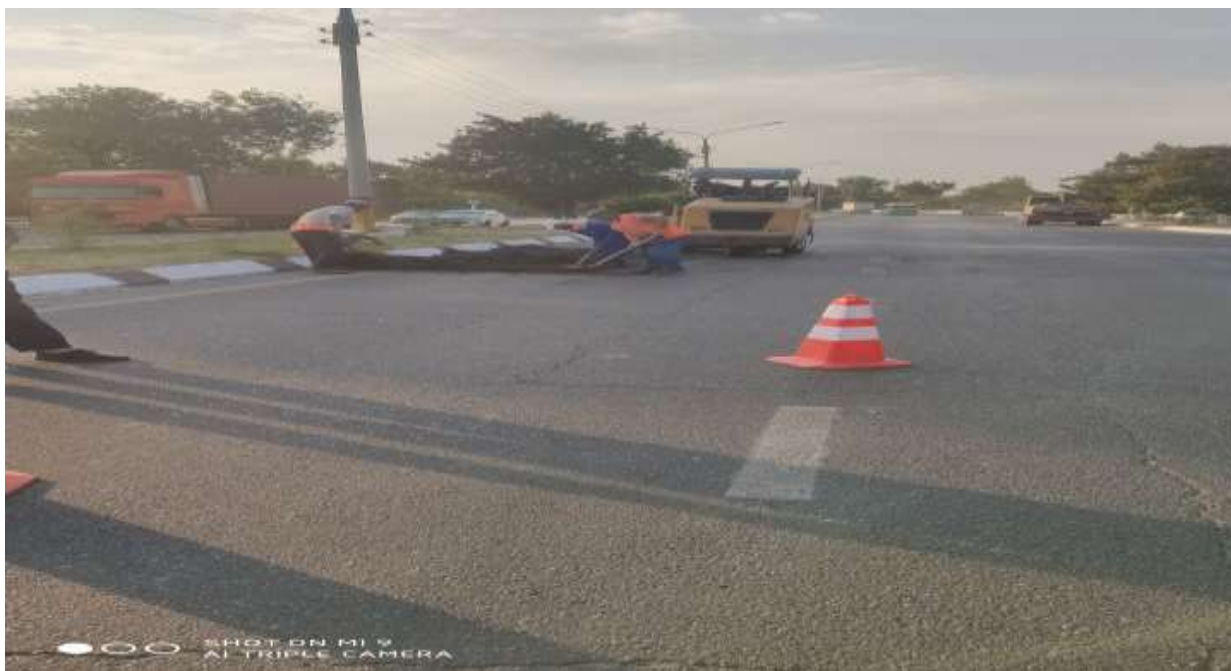
3-rasm. Ta’mirlanayotgan yo‘l bo‘lagidagi yo‘l belgi va to‘siqlarni o‘rnatilgan holati.
